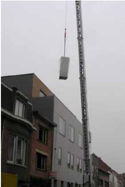
Levering van de wp in de lofts
